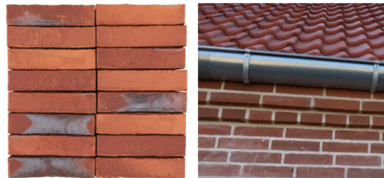
Rødbrune, blødstrøgne mursten med gesims
